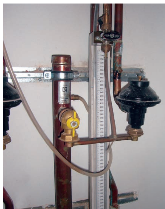
Prova de resistència mecànica i estanquitat de canonades de gas amb manòmetre de columna d'aigua.
