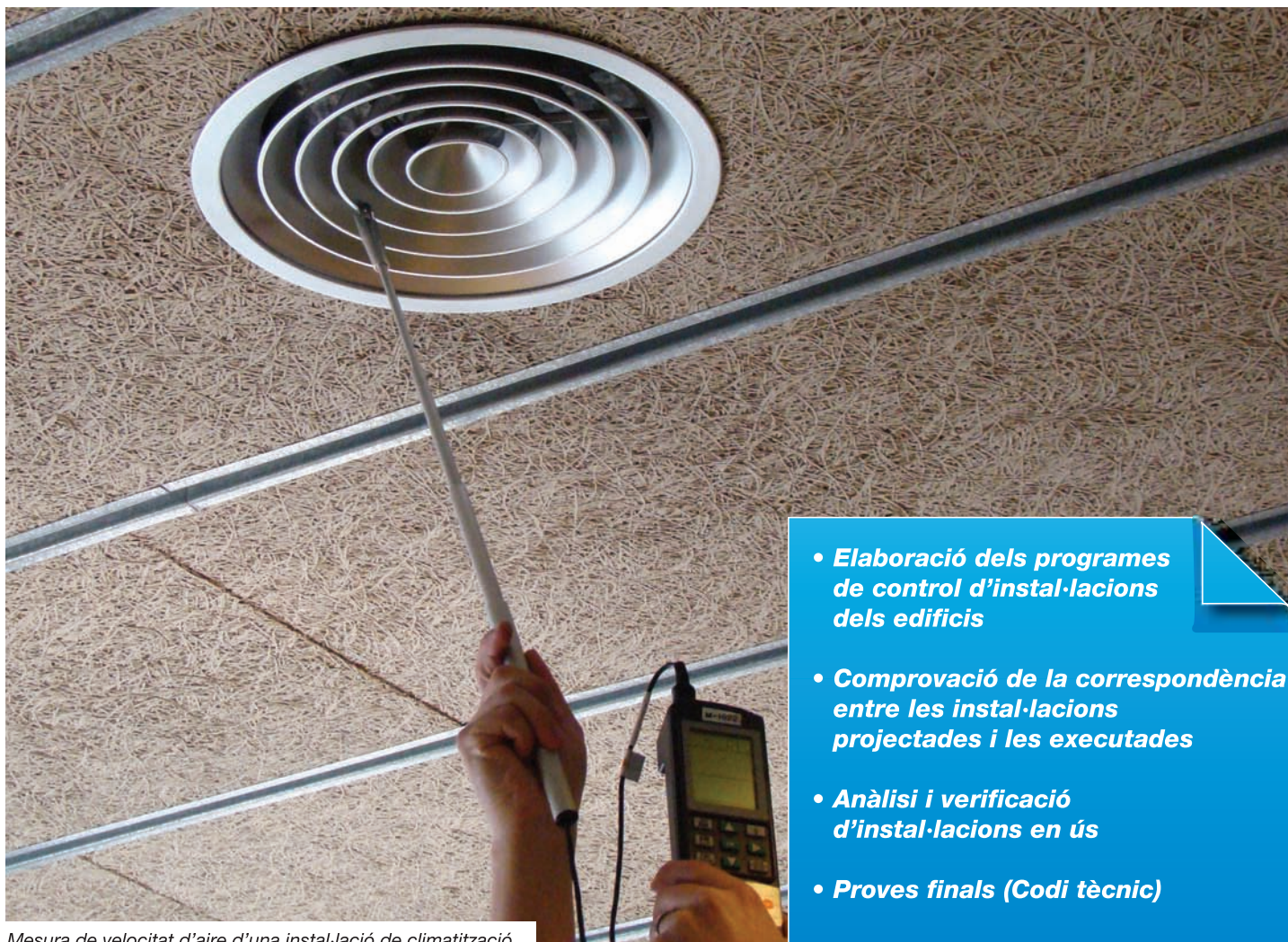
Mesura de velocitat d'aire d'una instal·lació de climatització.
