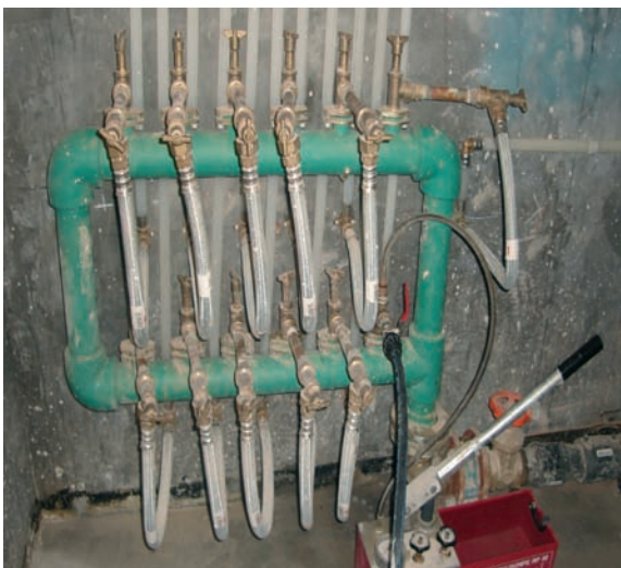
Prova de resistència mecànica i estanquitat de canonades de fontaneria des de la bateria de comptadors d'un bloc d'habitatges.
