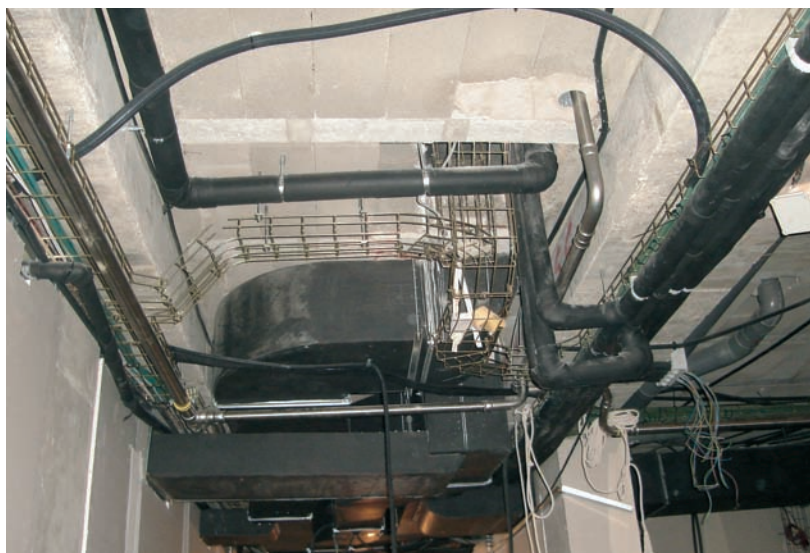
Control del pas de les instal·lacions per fals sostre.
