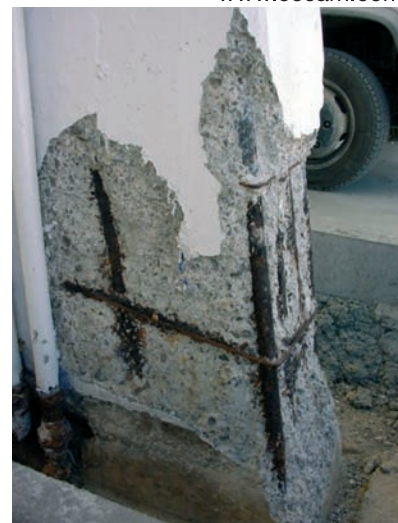
Estudi d'estructura de formigó afectada per la corrosió de l'armat.
