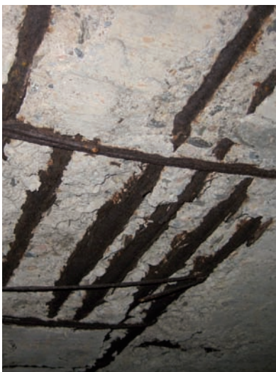
Estudi d'estructura de formigó afectada per la corrosió de l'armat.
