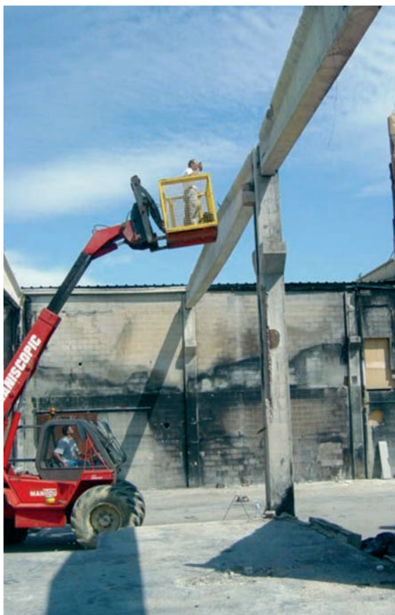
Estudi d'una estructura afectada pel foc.
