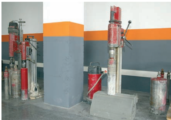
Perforadores per a l'extracció de mostres en formigó endurit.
