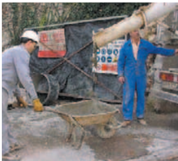
Operari realitzant la presa de mostres a peu de camió formigonera en una obra.
