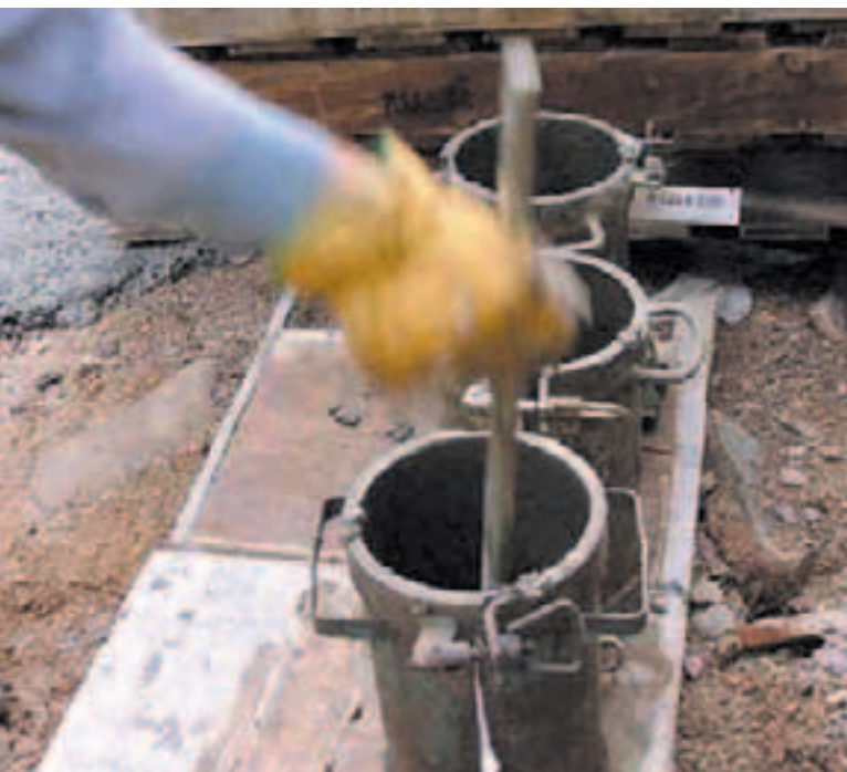
Fabricació i conservació de les provetes en una obra
