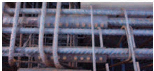
Obertures a portell a l'encofrat, amb colzes de 120° i els seus corresponents tubs.
