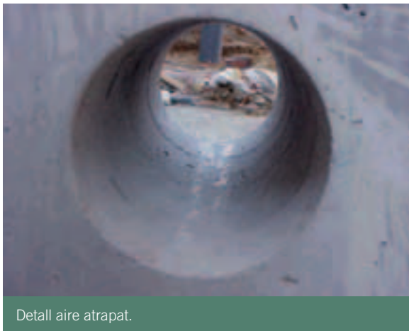
Obertures a portell a l'encofrat, amb colzes de 120° i els seus corresponents tubs.
