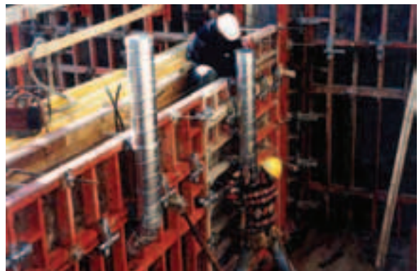
Obertures a portell a l'encofrat, amb colzes de 120° i els seus corresponents tubs.
