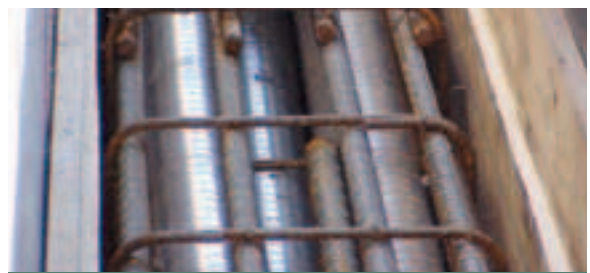
Detalls de l'armat, on es posa de manifest la seva densitat.
