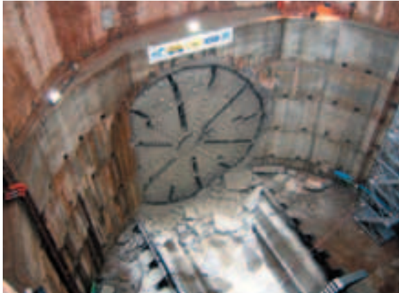
Figura 3: La tuneladora “Besi” emprada a la construcció del tram 4A de la línia 9 de Barcelona.
