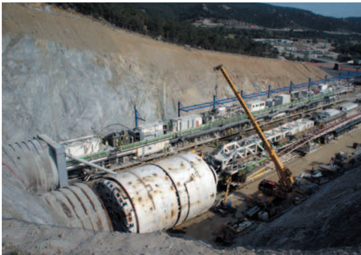
Figura 5: Vista de la introducció de les dues màquines que portaran un decalatge per a garantir l'estabilitat del procés d'excavació.
