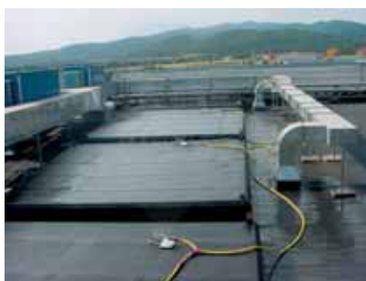
IMPERMEABILITAT DE COBERTES AMB ASPERSORS.
