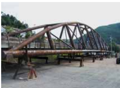
PONT SOBRE EL TER A RIPOLL
