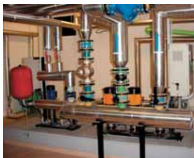
INSTAL·LACIÓ D'UN GRUP DE PRESSIÓ PER AIGUA POTABLE D'UN EDIFICI RESIDENCIAL.
