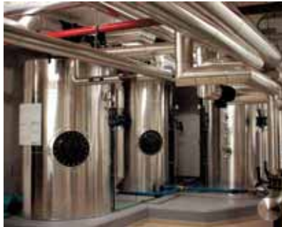
INSTAL·LACIÓ DE DIPÒSITS D'AIGUA CALENTA SANITÀRIA.
