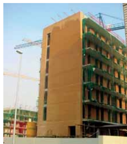
ESTANQUEÏTAT DE FAÇANES.
