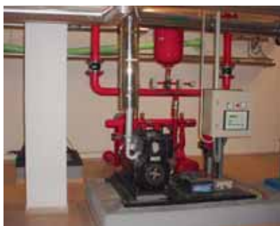
INSTAL·LACIÓ D'UN GRUP DE PRESSIÓ PEL SISTEMA DE PROTECCIÓ CONTRA INCENDIS D'UN EDIFICI RESIDENCIAL.
