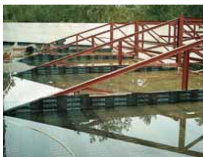
IMPERMEABILITAT DE COBERTES.
