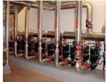
INSTAL·LACIÓ DE COL·LECTORS DE CALEFACCIÓ.
